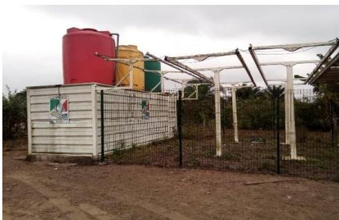
**Photo 1 :** Forage implanté au village Ngobana qui n'a fonctionné que pendant deux semaines, après quoi, les panneaux solaires ont été volés, source O.L. MOATILA, 2019
