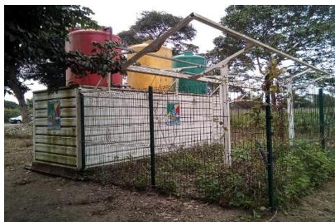
**Photo 2 :** Forage implanté au village Inkouélé, exploité pendant une année et abandonné suite à la panne du dispositif technique. Par la suite, les panneaux solaires ont été volés, source O.L. MOATILA, 2019
