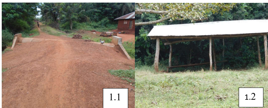
Planche 1 : Infrastructures réalisées dans le village d'Akouho
