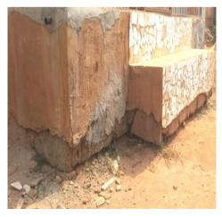
**Photo 5 :** Déchaussement d'une fondation à Aglogbè Prise de vue : Koussinou, juillet 2016
